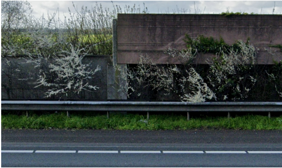
Figuur 13 Aanzicht twee schermdelen langs de A12 met een laag deel (links) en een hoger deel (rechts). Foto Google Streetview
