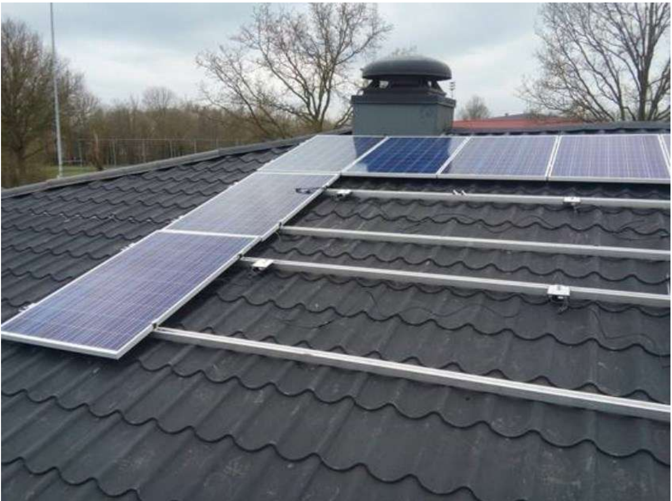
Figuur 11 Horizontale bevestigingslatten onder zonnepanelen
