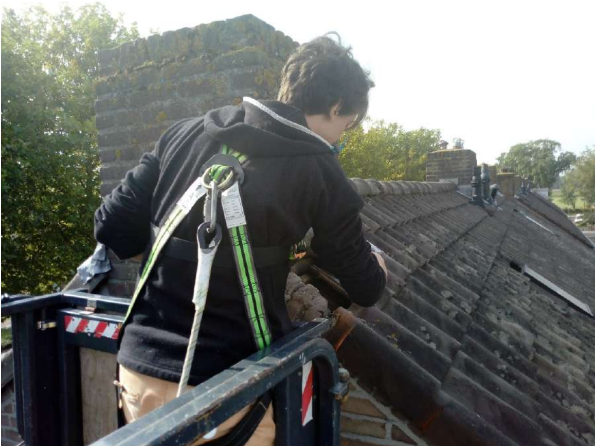
Visuele inspectie van een dak door een ecooloog gericht op het vinden van verblijfplaatsen (Bron: Arcadis).
