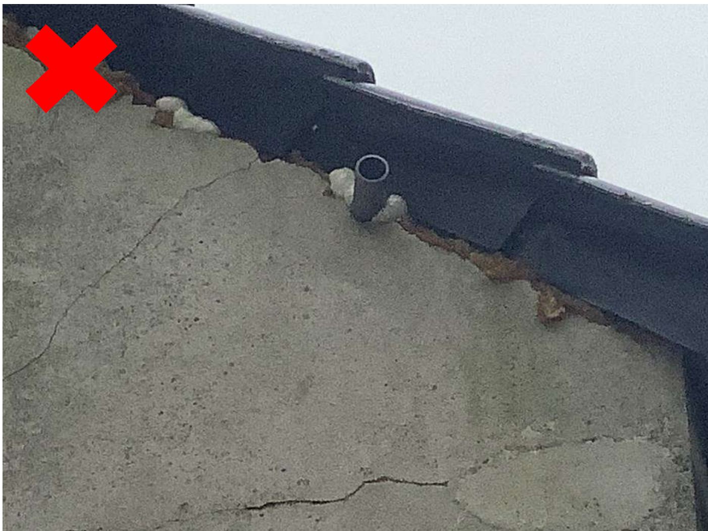
Figuur 5 Foutieve 'exclusion flap' (het pijpje)
