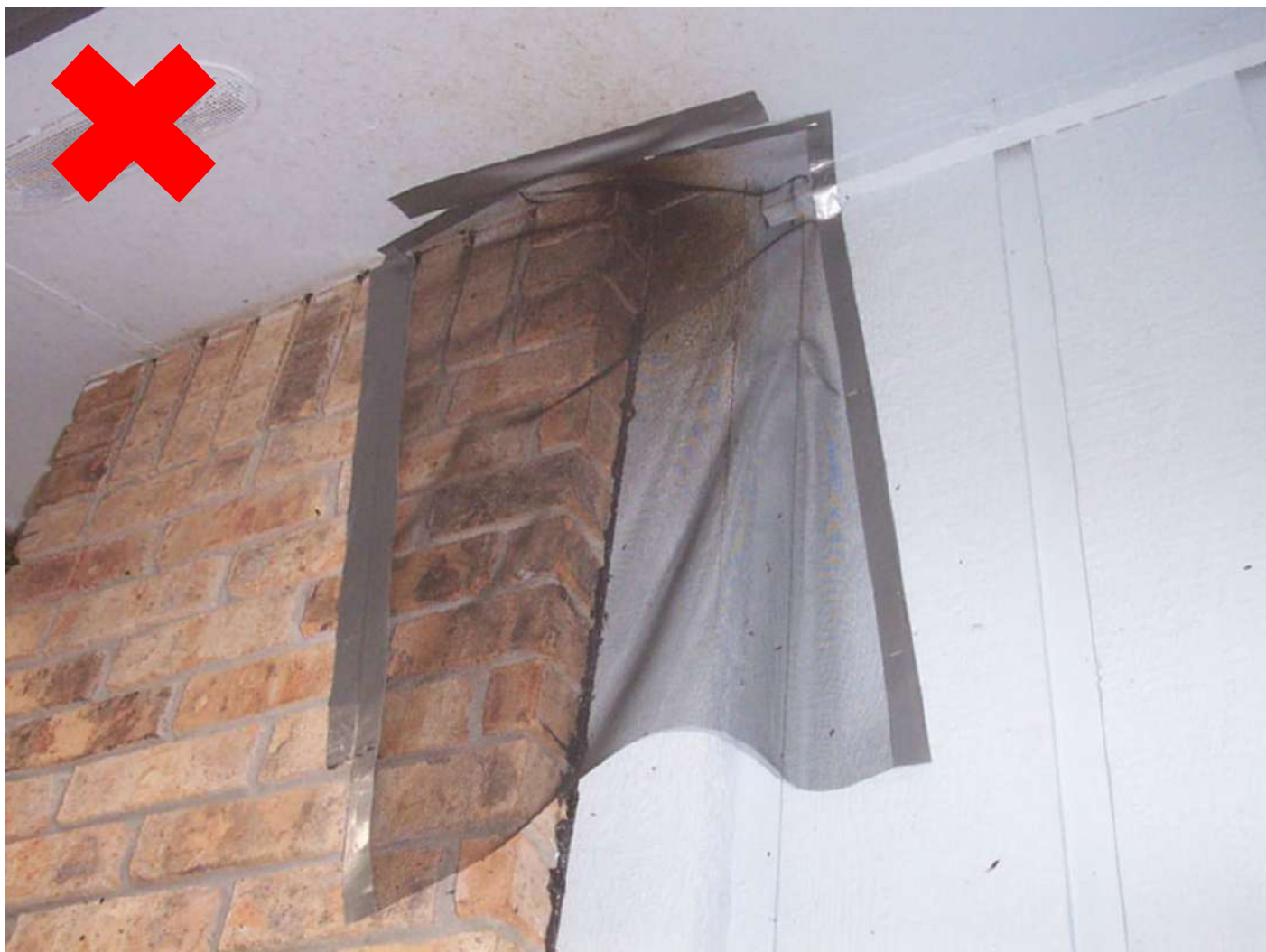
Figuur 4 Foutieve toepassing van exclusion flaps
