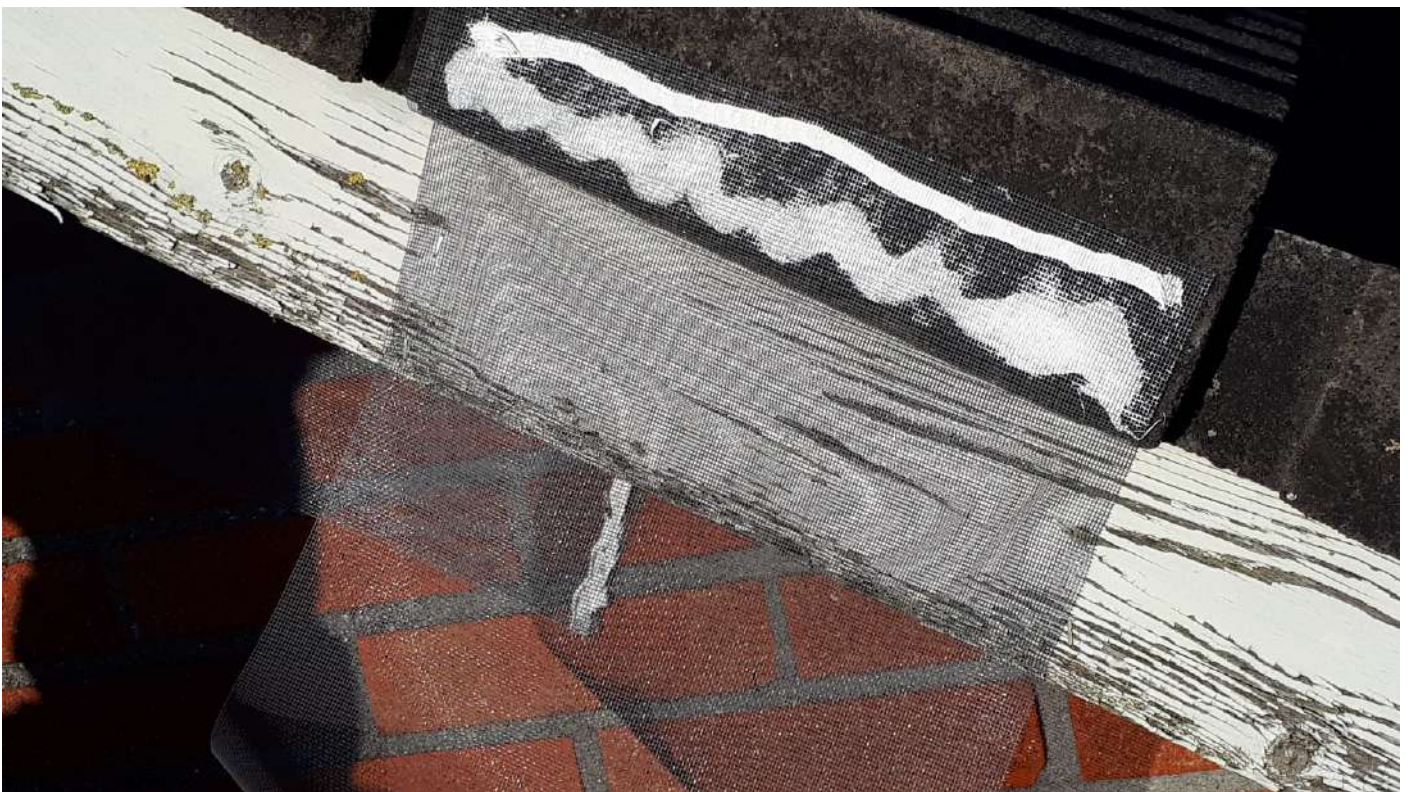
Figuur 3 Goed voorbeeld van exclusion flaps van fijnmazig gaas. De zijkanten zijn hier met nielen en lijm vastgezet
