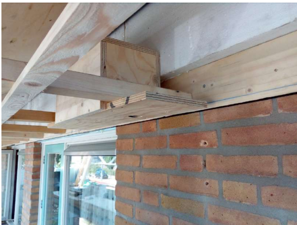
Vogelkast (maatwerk) in nieuwe en ruimere dakoverstek. Hierbij kan de invliegopening dichtter bij de muur geplaatst worden zodat huismussen via de muur de invliegopening in kunnen (optimalisatie maatregel) (Bron: Arcadis)
