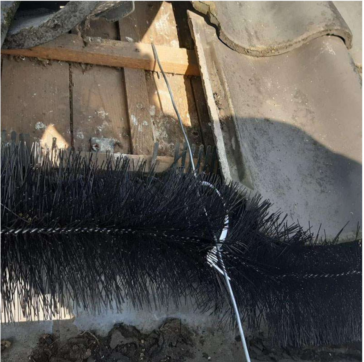
Figuur 7 Spouwborstel vastgezet met borstelhaak (Bron: Unitura.nl)
