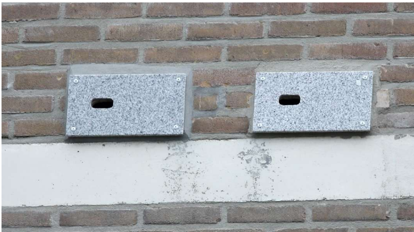
Halsbandparkieten die gierzwaluwkasten kraken, Als oplossing kan een marmereenplaat toegevoegd worden over de kasten (Bron: Vivara Pro)
