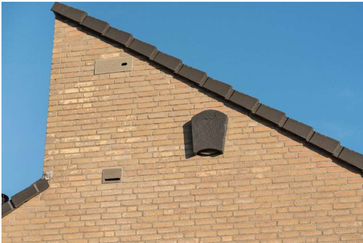
Entreesteen ingebouwd (links onder) in combinatie met een inbouwkast gierzwaluw en een opbouw vleermuiskast (tijdelijke mitigatie) (Bron: Vivara Pro)
