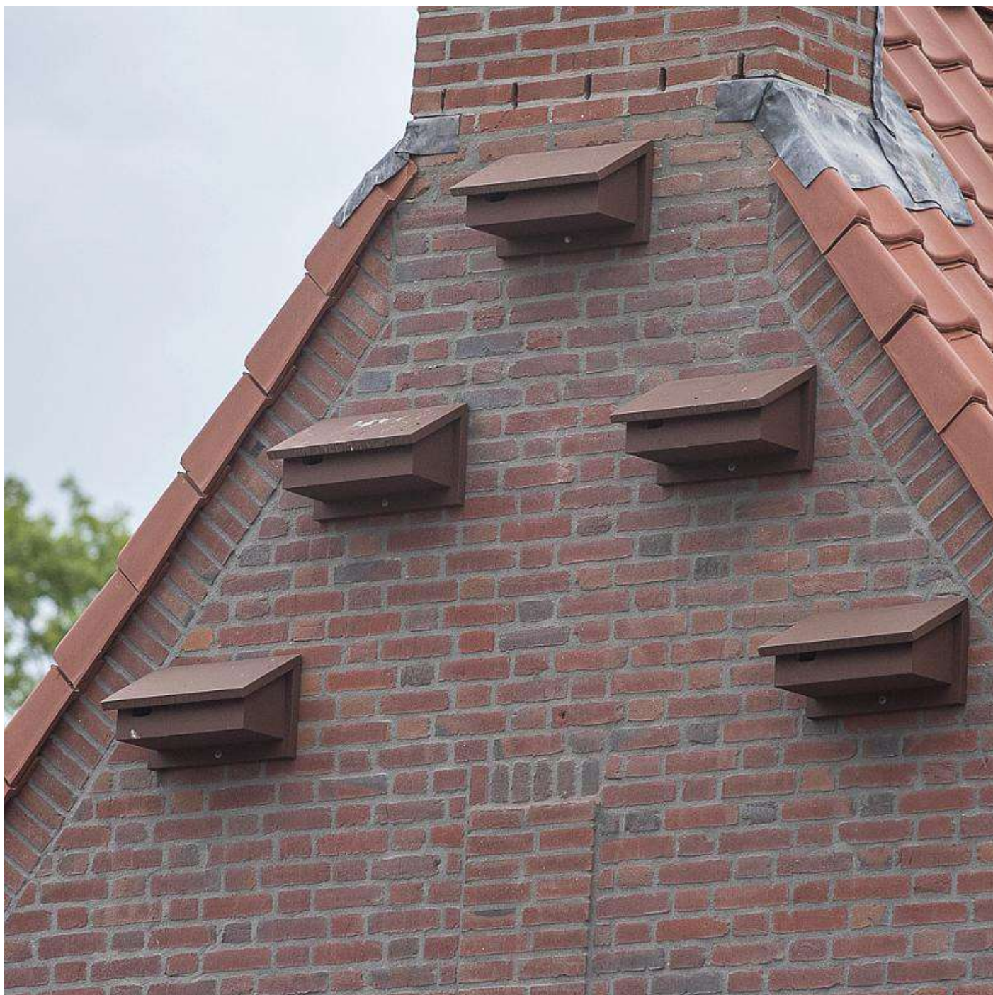
Voorbeeld houtbetonnenkasten voor gierzwaluw van Vivara Pro type NK GZ 10 (bron: Vivara Pro)
