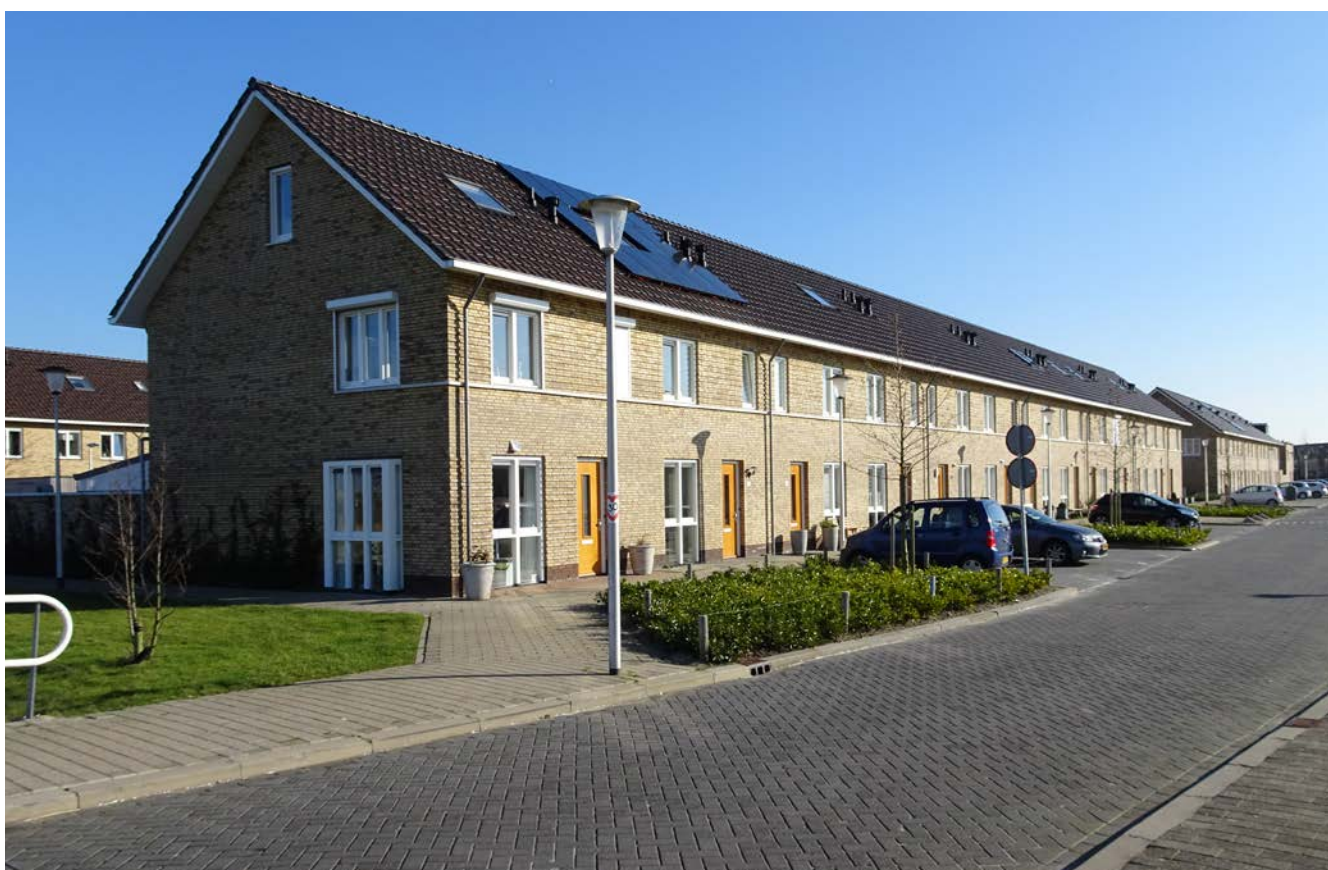
De proefwoning in Berkel en Rodenrijs heeft een bodemlus onder het plantsoen direct voor het huis, zonnepanelen op het dak en een compact warmtepompsysteem in de woning.
