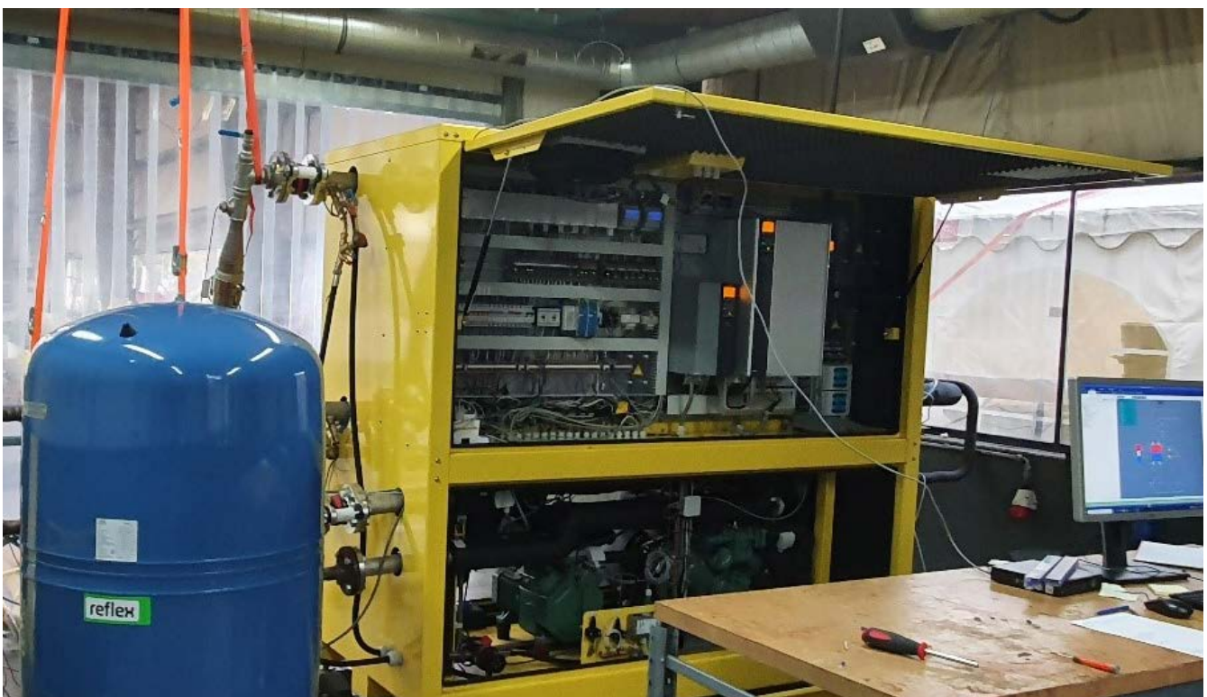
De verdamer die straks op het dak van het gebouw komt, opgesteld in een tent om ook in de zomer bij lage luchttemperatuur te kunnen testen.
