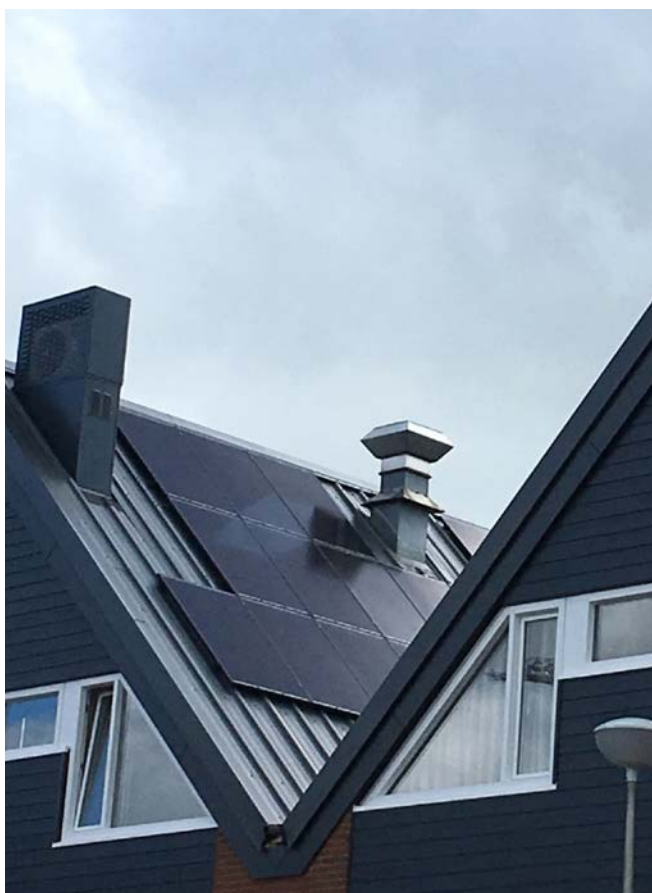
Het systeem is in vijf demowoningen getest.
