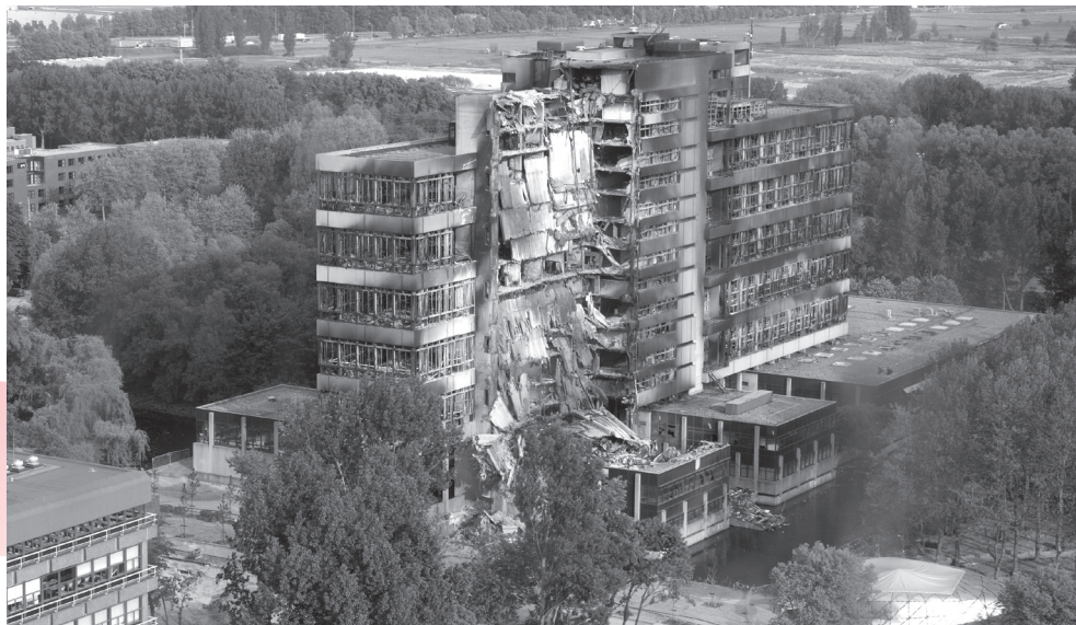
13 mei 2008: De brand in het faculteitsgebouw Bouwkunde van de TU Delft (een ontwerp van het architectenbureau Van den Broek en Bakema, 1970) beschadigt het gebouw zodanig dat het wordt gesloopt.
