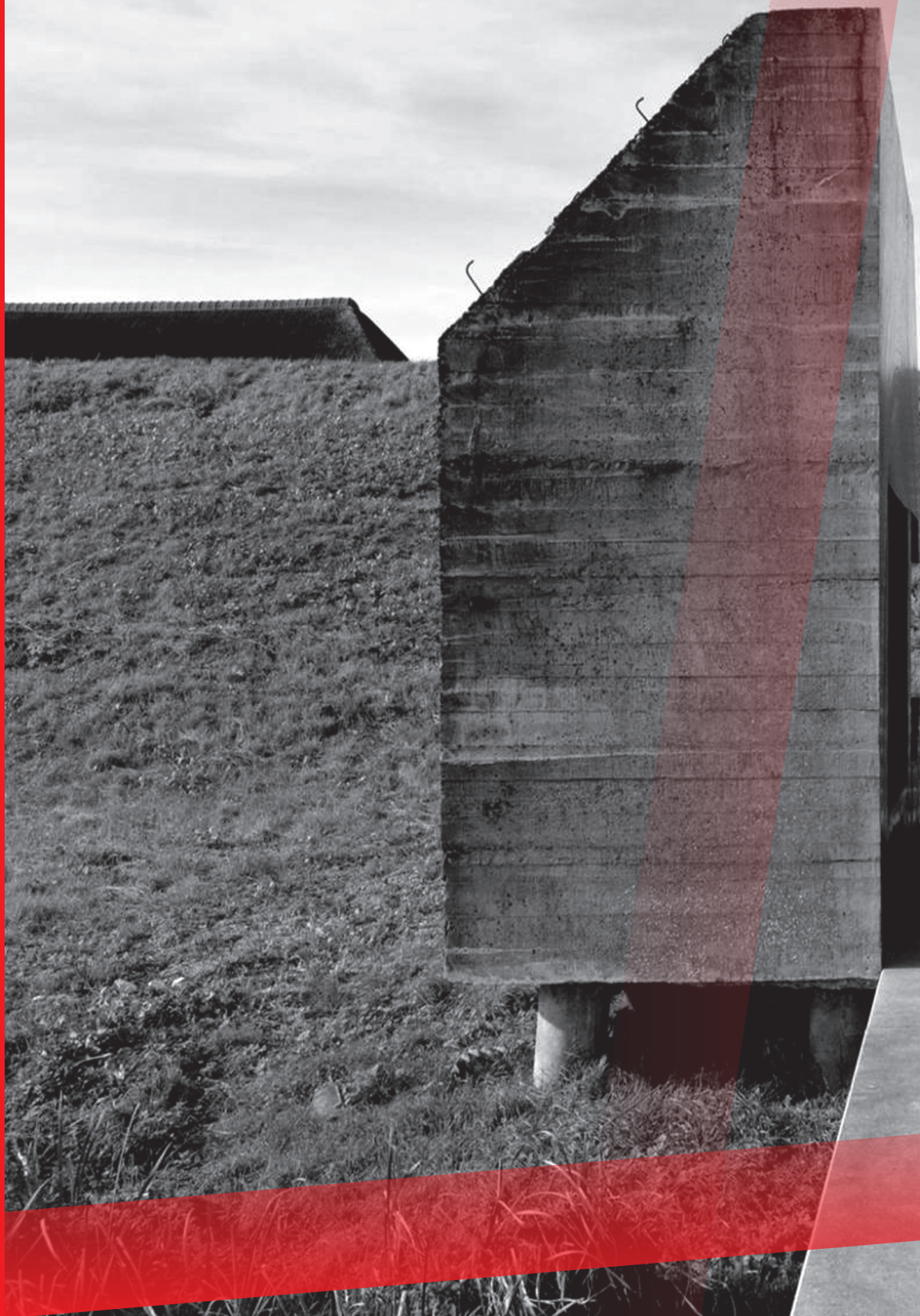
Bunker 599 - onderdeel van de Nieuwe Hollandse Waterlinie © Jeroen Bosch
