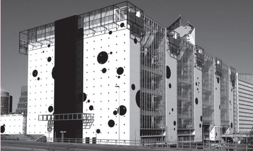
Het Atelier Rijksbouwmeester heeft inmiddels Noordeinde verlaten. Het behoudt zijn naam 'Atelier Rijksbouwmeester' maar heeft een herkenbare plek en een eigen voordeur in het VROM-gebouw gekregen. Ter gelegenheid van het 200-jarig bestaan van de Rijksbouwmeester in 2006 markeert het kunstenaarsduo Zeger Reyers en Pietertje van Splunter (BROOS) het VROM-gebouw met 'zwarte stippen'. Dit tijdelijk kunstwerk symboliseert het waakzame oog van de Rijksbouwmeester. © Martin Zwaan
