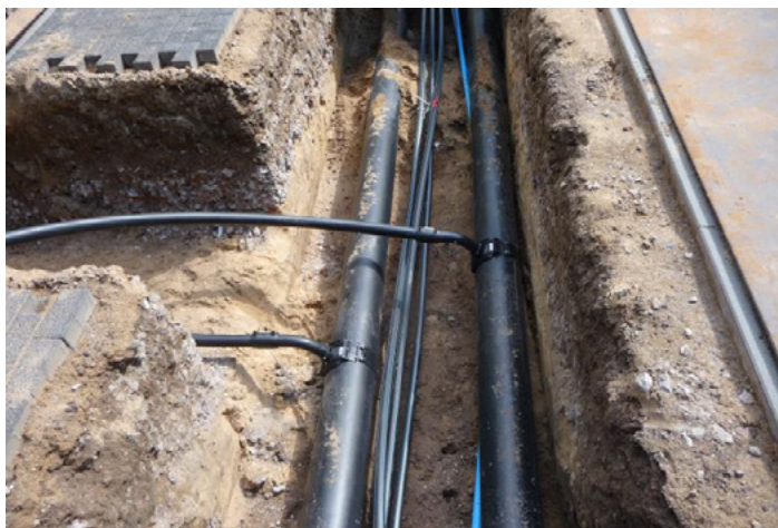
Figuur 7.9 | voorbeeld twee-pijps distributienet met aftakking
