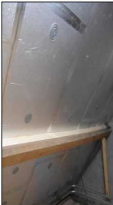
Afb. 6 Isolatie op vliering tussen de gordingen
