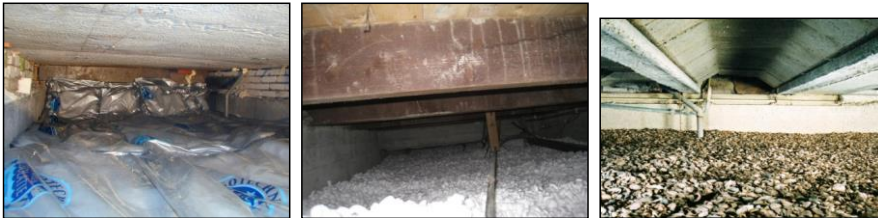
Afb. 8 Isolatie in de kruipruimte, met respectievelijk isolatiedekens, parels en schelpen
