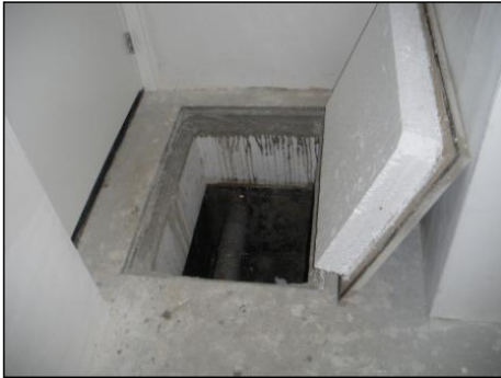
Afb. 7 Isolatie in de vloer
