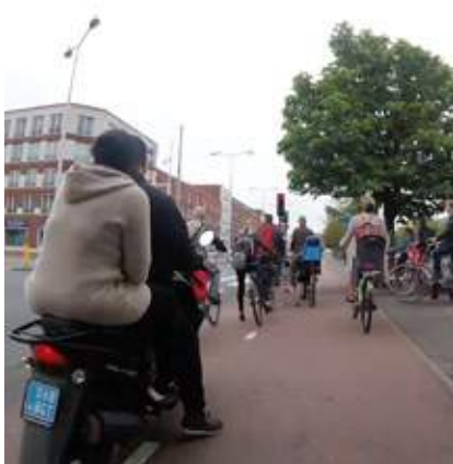
Opstelvakken bij verkeerslichten zijn overvol. De maatvoering voldoet niet met het aantal fietsen dat er gebruik van maakt.
