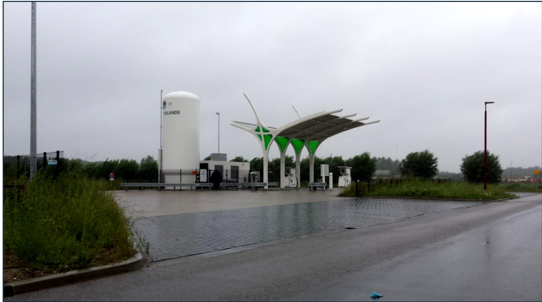
Figuur 1.1 LNG-tankstation Nieuwegein
