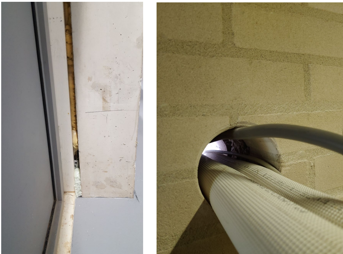
Figuur 3.12: Deze bouw is niet knaagdierproof (bron: Alex Mars, Mega-Des).
