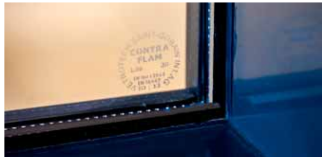
N.B. de hoek waarin de stempel in het brandwerend glas is gemarkeerd, dient aan de onderzijde te worden gemonteerd
