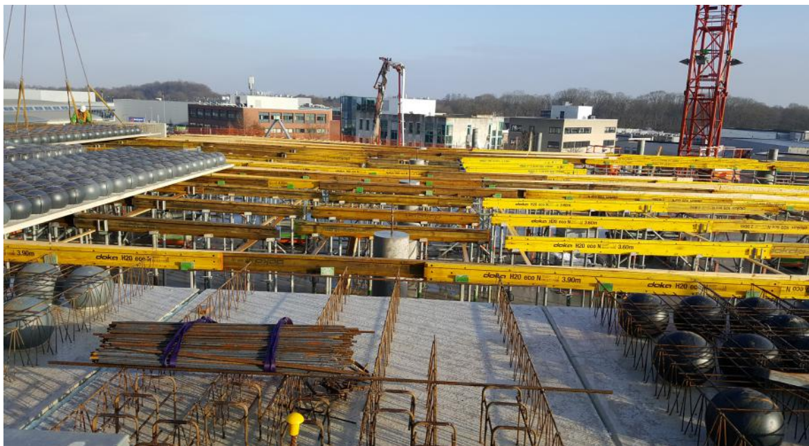
Figuur 65: Oriëntatie 4B 2-3 plaatsen breedplaten 10 januari 2017.
