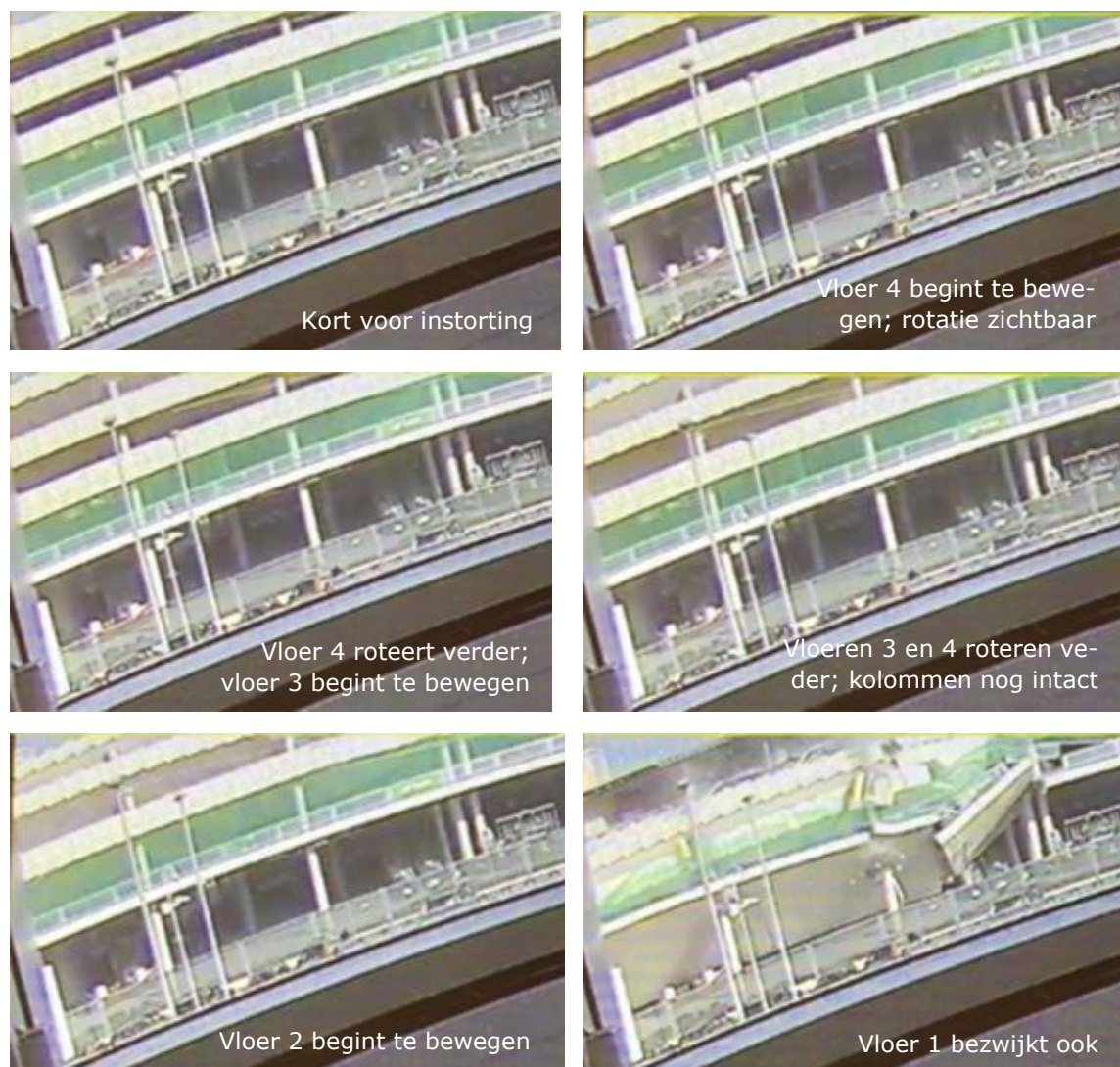
Figuur 6: Beelden van het verloop van de instorting. [008]
