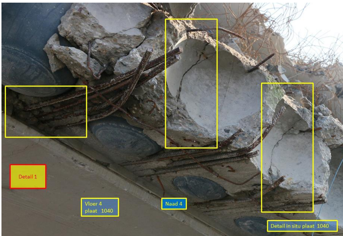
Figuur 48: Oriëntatie detail vloerveld 4 tussen breuklijn 3 en naad 4 gezien vanaf onderkant ter hoogte van de stortnaad.
