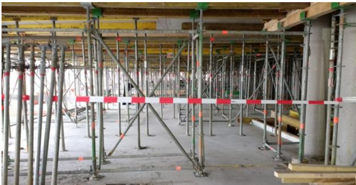
Figuur 68: Oriëntatie 2B- 1 De foto toont vele op spanning (krom)staande losse stempels 27 januari.
