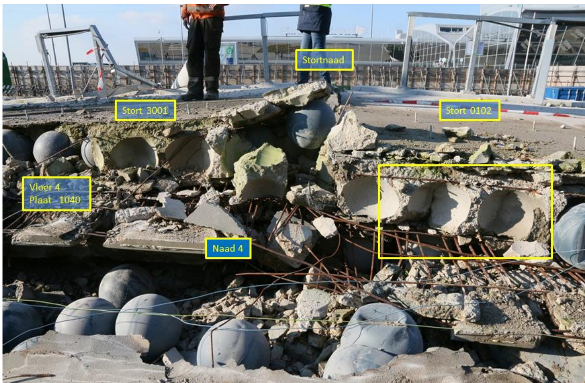
Figuur 42: Oriëntatie van de breuk 3 in vloer 4 gezien in de richting van de terminal.
